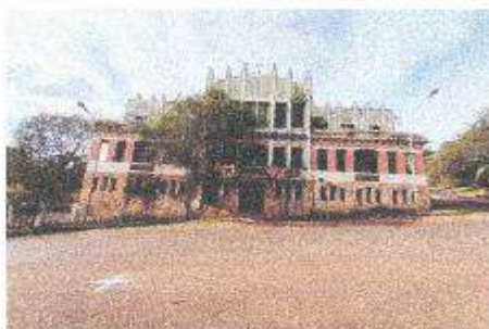
Vista do Imóvel Avaliando
